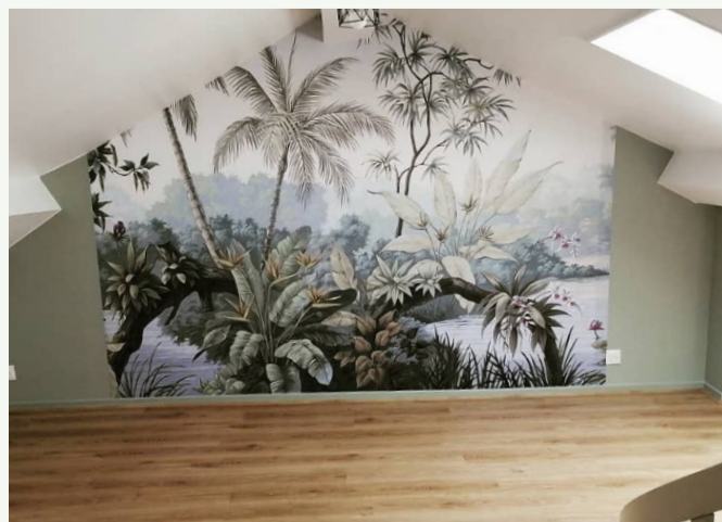
Rénovation sols et murs par SARL A.LAROCHE
