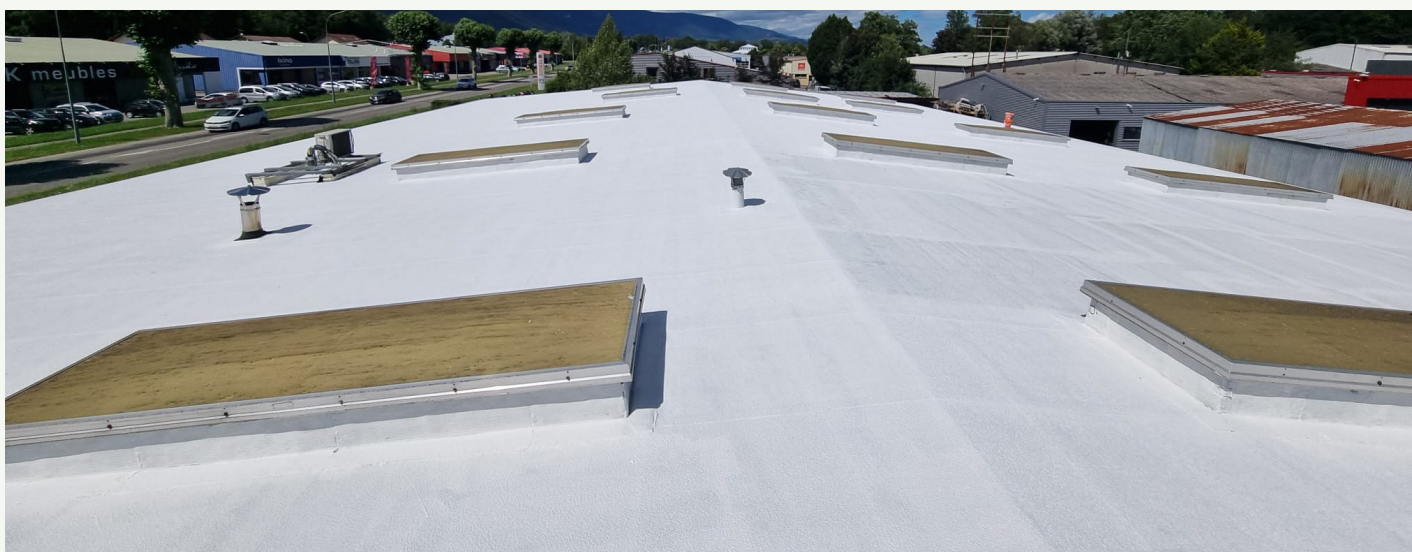
Cool Roofing réalisé par notre client GAILLARD LUDOVIC.
