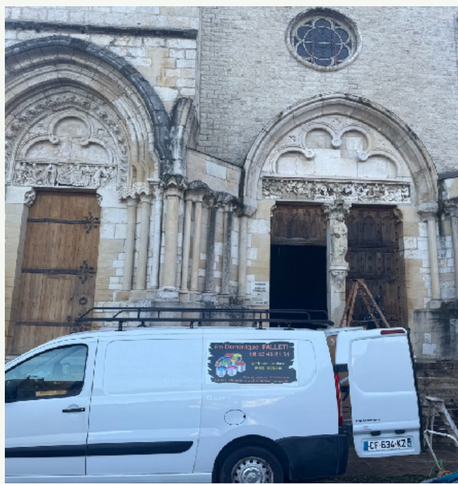
Restauration des portes d'une abbaye par l'ent. Dominique Falletti
